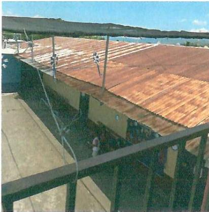
Foto 3: INSTALACION DE LÁMINA TROQUELADA EN AULAS. (MODULO II)
