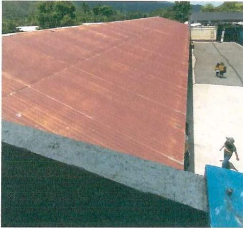
Foto1: INSTALACION DE LÁMINA TROQUELADA EN AULAS Y DIRECCION. (MODULO I)
